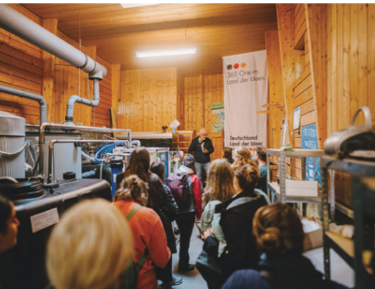
Führung Roof Water Farm: Der Ingenieur Erwin Nolde zeigt die Grauwasser-Aufbereitung der Filter an der Roof Water.
